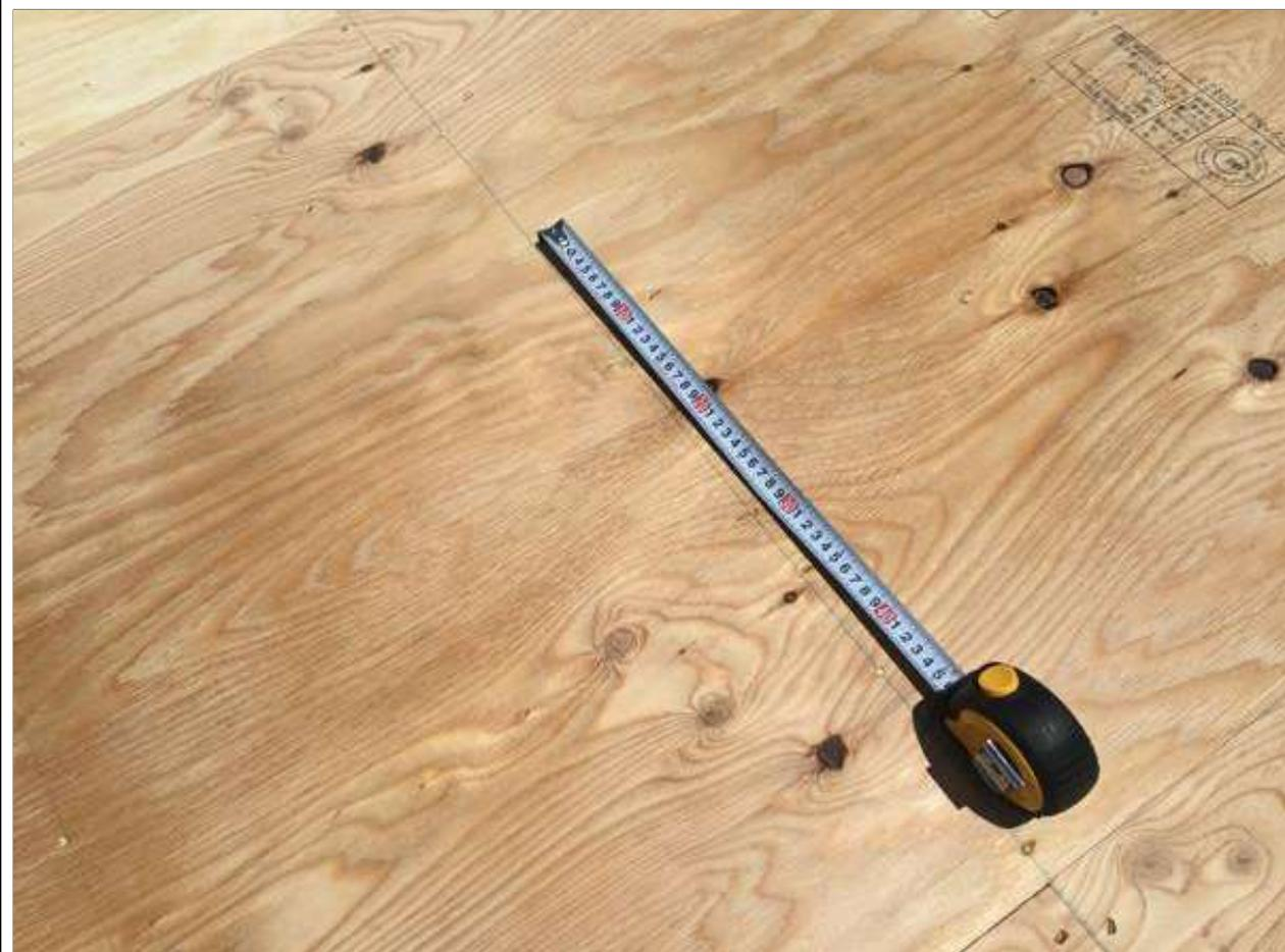
1-19 内側から見て屋根に外し釘がないか確認する。釘は合板端部より10～15mm離す。
