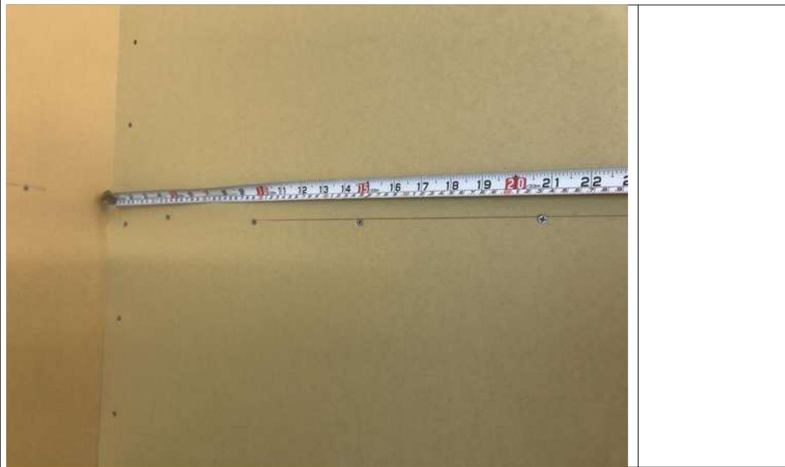
1-15 くぎ打ち間隔は外周100mm以内、中間部200mm以内の間隔で留め付ける。(2枚張りの場合) くぎ打ち間隔は外周部及び中間部とも200mm以内とする。(2/2)
