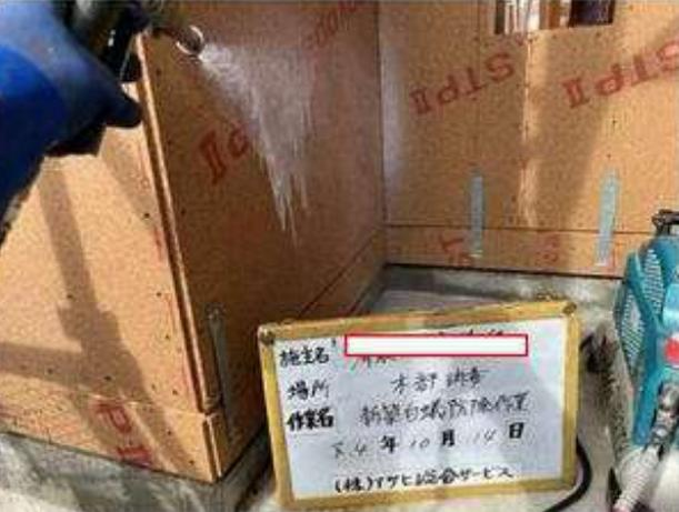
1-7口地面からの高さが1m以内の外壁の枠組の防蝕・防蟻措置を現場で塗布・吹付をする。
