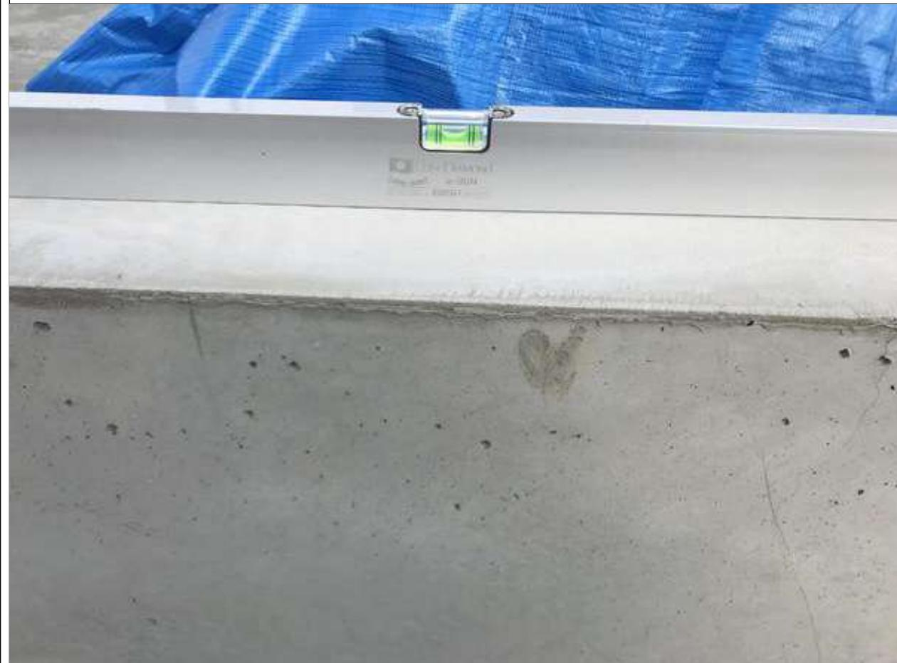
1-5口鋼製束施工前に基礎内を掃除機で掃除する。鋼製束の間隔は前後左右1m以内を保ち、接着剤がはみ出るまで圧着する。
